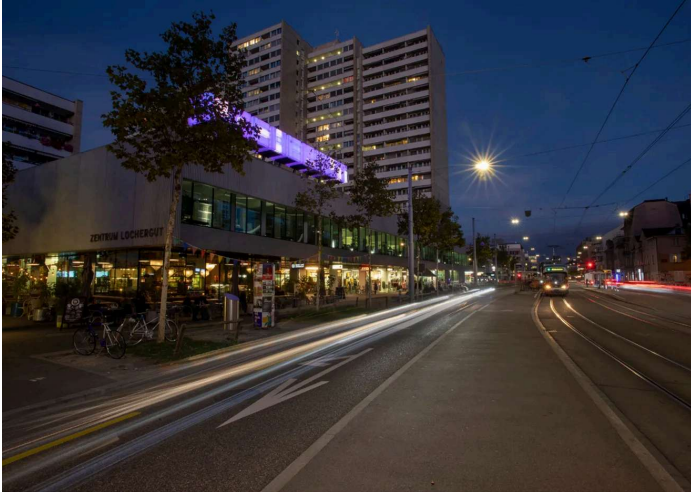
Zentralmassiv des Viertels: das 21-stöckige Lochergut © Nico Schaerer
